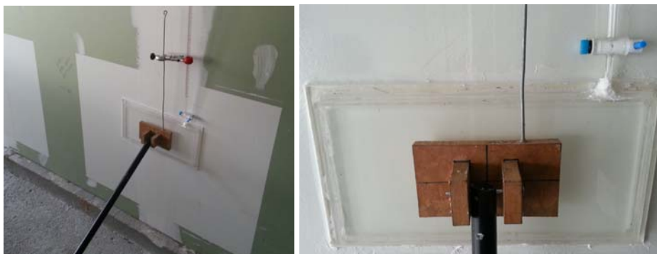
Figura 20– Foto ilustrativa do ensaio de permeabilidade à água realizado em SVVI com chapa de gesso resistente à água - RU com revestimento em tinta epóxi base solvente
