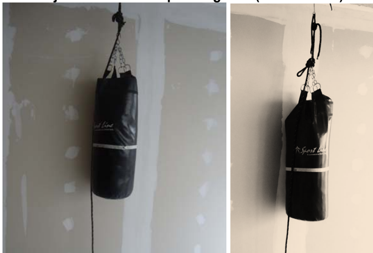
Figura 6 – Fotografias ilustrativas do ensaio, com o saco de areia posicionado em repouso faceando a parede, sobre o ponto médio entre dois montantes consecutivos (foto à esquerda) e sobre a junta entre as chapas de gesso (foto à direita)
