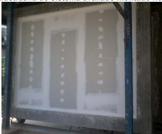
Figura 23 – Foto ilustrativa do sistema avaliado montado no pórtico de ensaio
