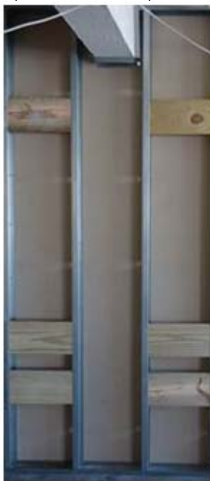
Reforço de madeira (1 linha na parte superior e 2 linhas na parte inferior)
