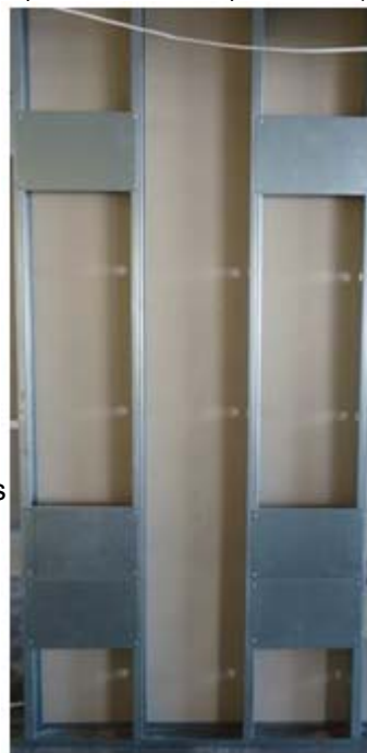
Reforço metálico (1 linha na parte superior e 2 linhas na parte inferior)
