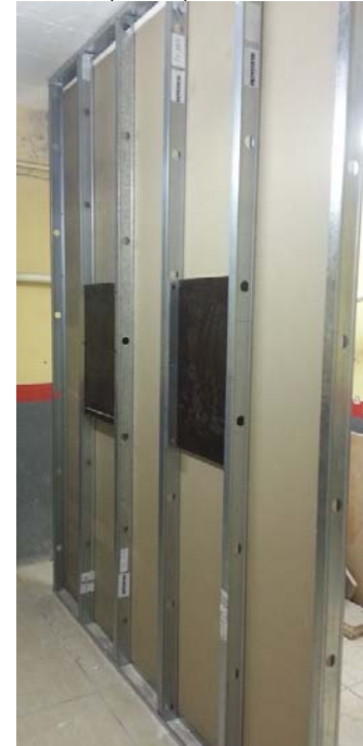
Reforço de compensado plastificado de madeira (1 linha)
